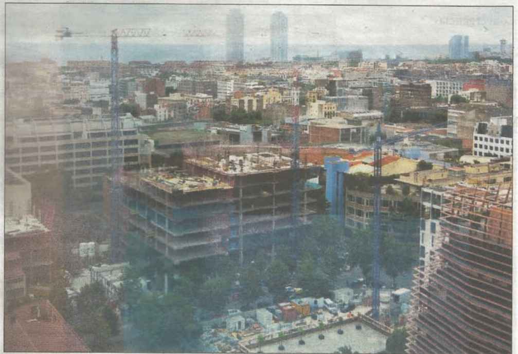
Vista de la construcción del edificio Luxa Silver para la futura sede de Amazon en Barcelona. / MIRIAM LÁZARO
